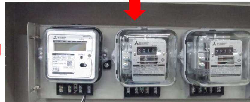
นำมิเตอร์ SX1 รุ่น C-Loop ติดตั้งแทนตรงตำแหน่งมิเตอร์เดิม
