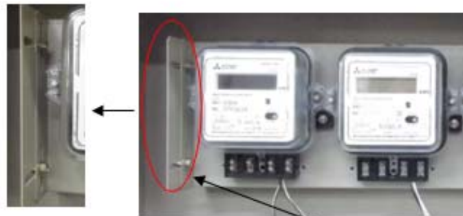
ไขสกรูเลื่อนระดับเป็นรองขึ้น
