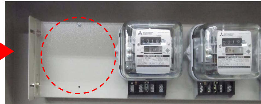
ถอดมิเตอร์จานหมุนเดิมออก
